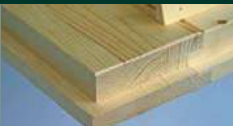
Optimale Auflage der Dachbretter durch abgeschrägte Seitenwandbohle
