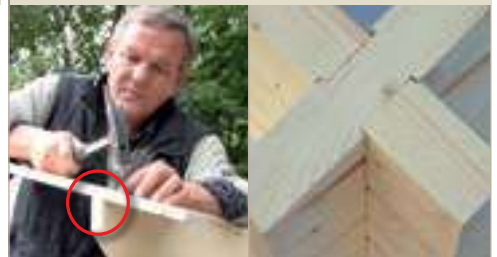
Optimale Auflage der Dachbretter durch abgeschrägte Seitenwandbohle
