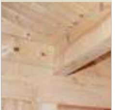
Dachpfetten 70x180 mm; Dachbelastbarkeit über 180 kg/m 2
