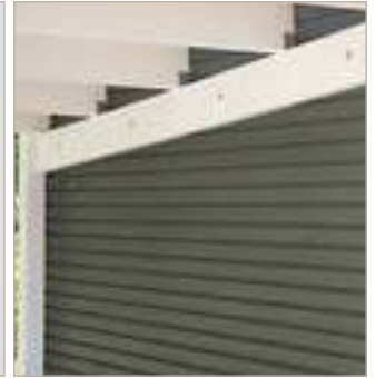
Stabile Dachkonstruktion bei den Seitendächern
