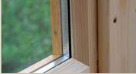
Isolierverglaste Leimholz-Türen mit verzinkter Türschwelle und Dichtung
